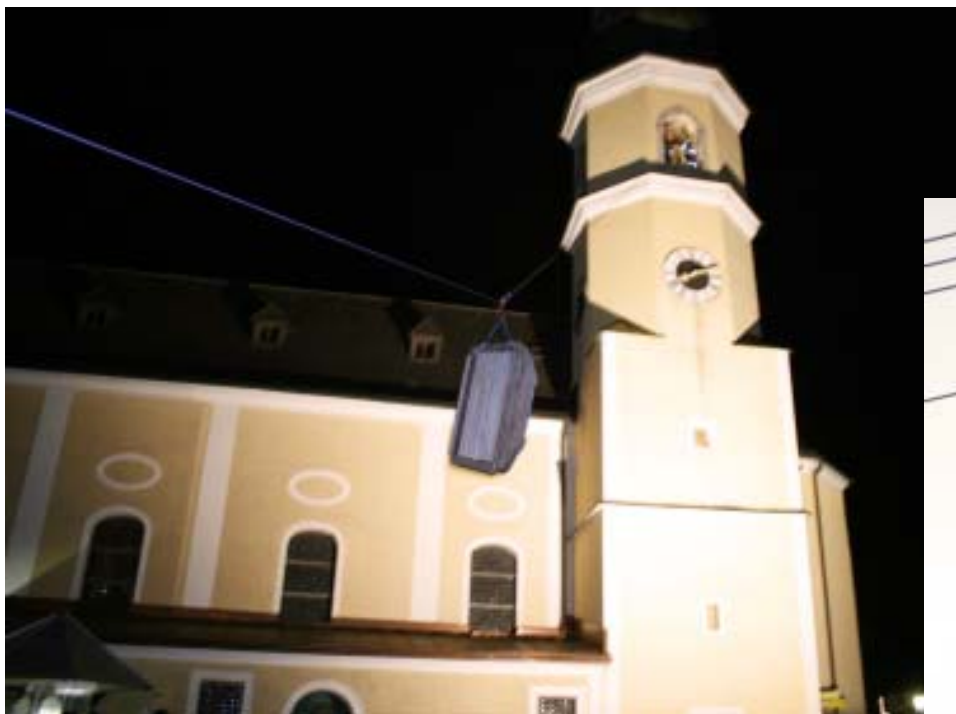
Demontage der großen Fensterflügel an der Pfarrkirche in Helfenberg
