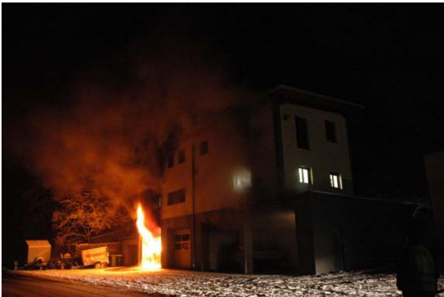
Durch die rasche Alarmierung und den bestens koordinierten Feuerwehreinsatz konnte der Schaden beim Brand in Waldhäuser gering gehalten werden.
